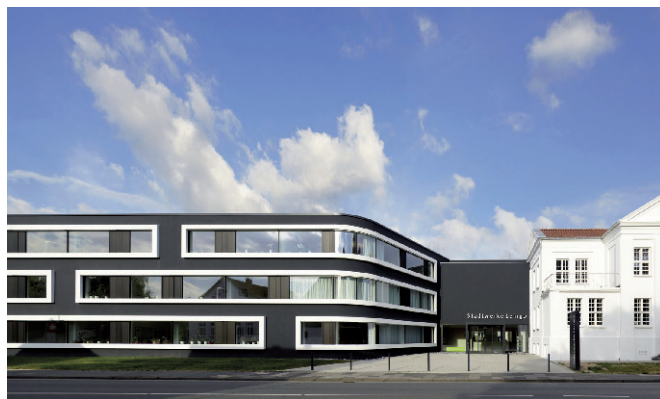
Die Verwaltung der Stadtwerke Lemgo: Alt- und Neubau mit neuem Eingangsbereich.
