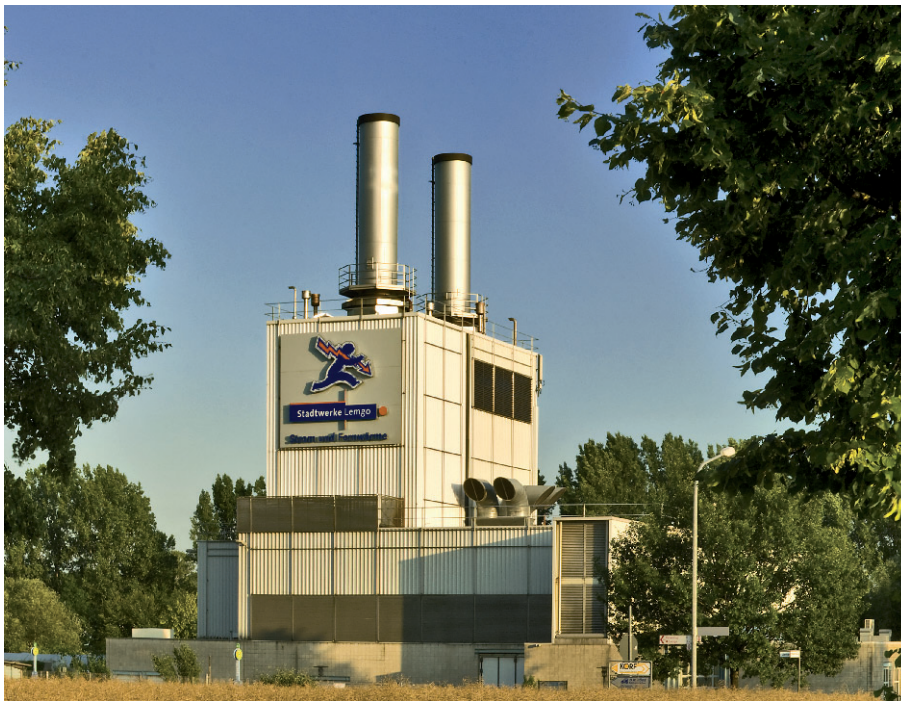
Das Heizkraftwerk West der Stadtwerke Lemgo. Zwei Gasturbinen – Flugzeugturbinen von Rolls Royce – erzeugen nach dem KWK-Prinzip Strom und Fernwärme.
